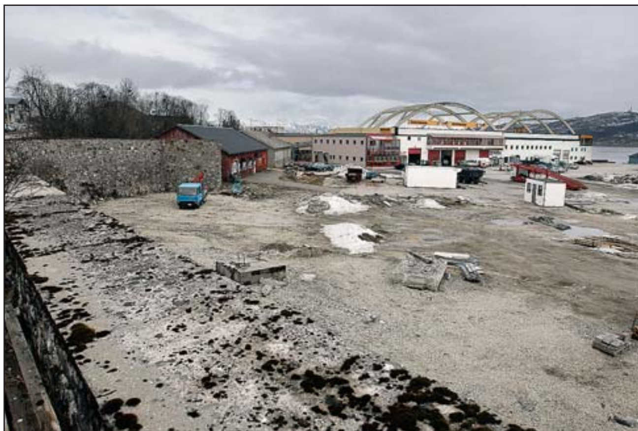
SKATTØRA 2007: Slik lå det samme området våren 2007 – med deler av splintmurene i bildet. Den kom som kjent ikke før i 1943. På bildet er betongplattformen alt rasert av en utbygger, og nå står splintmuren for tur – hvis ny entreprenør skal bygge ut. De to brakkene til venstre, sto ferdig alt høsten 1940. Foto: Per Eliassen
